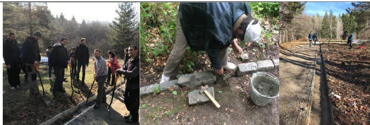
✓ Почистване от отпадъци:
