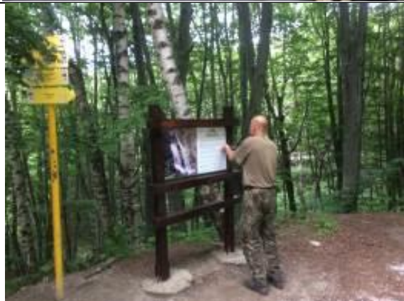
✓ Ремонт на информационно табло на Алеята на билките и подстълбищното пространство в сградата на детски екостанционар “Бели брзи”:
